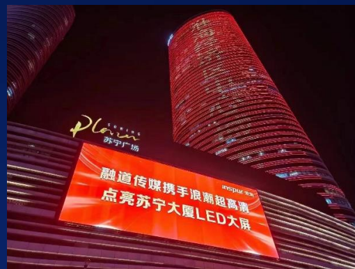
徐州苏宁广场双4K大屏项目
