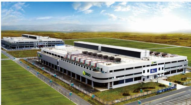
“美利云中卫数据中心”于2014年投建，总占地面积600亩，总建筑面积约20万平方米，规划建设数据中心机房10栋，可容纳高密机柜2万余个，服务器30-40万台。
