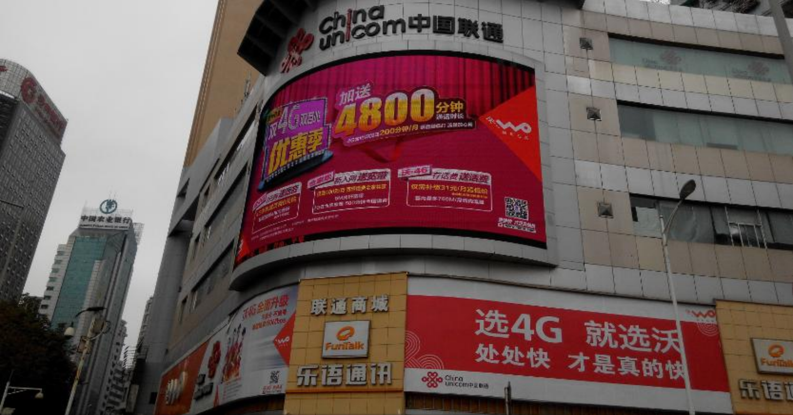
贵阳联通室外显示屏
